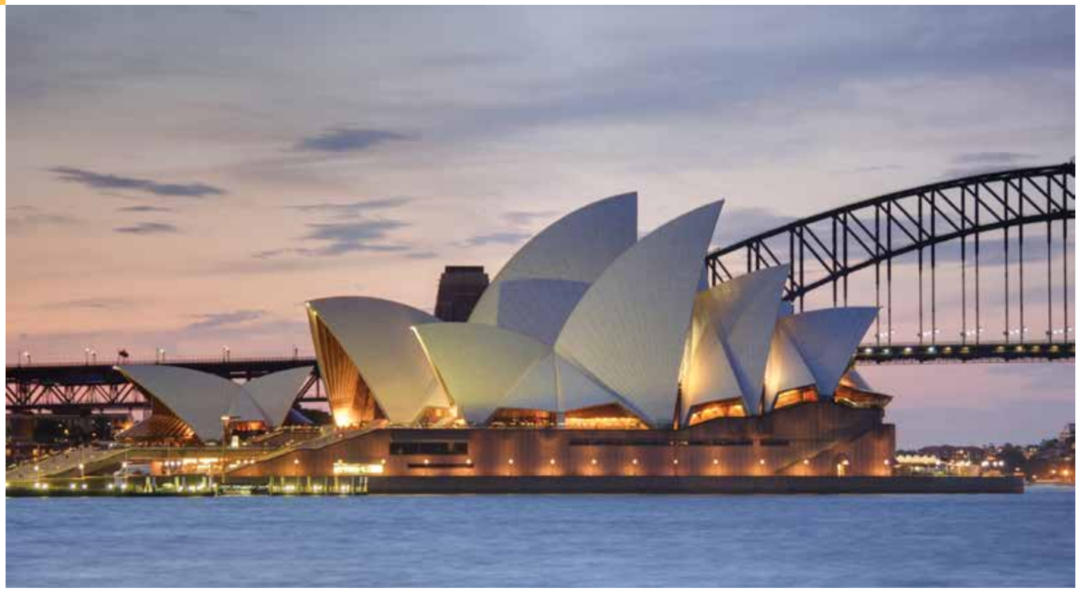
Sydney Opera House, Australia; Source: Wikimedia Commons
